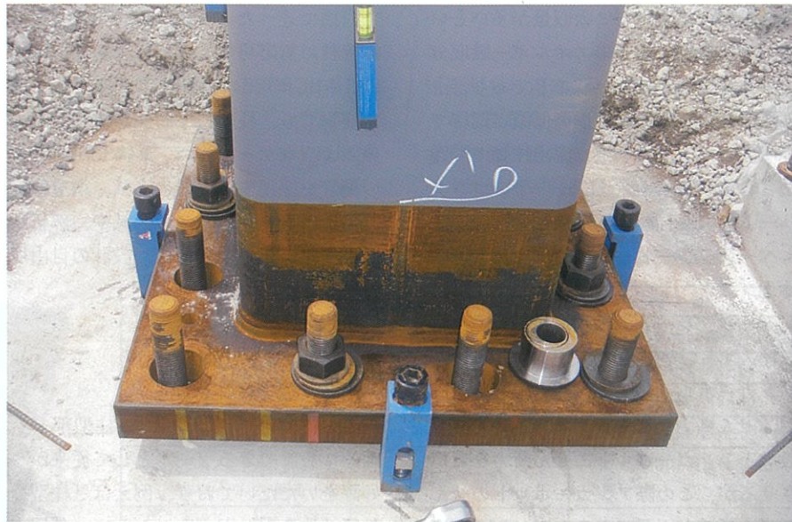
▼OF48 (M48)のアンカーボルト 手戻りもなくスムーズに作業を終えた
