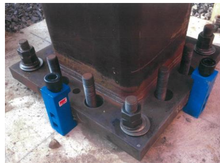
<柱脚の施工例 (M48)>
