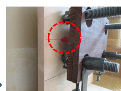
●08 鉛直方向へ位置合わせ ※M10 ラチェットスパナを使用
