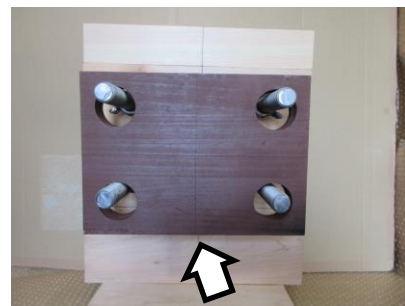
●06 ブラケット仮置き ※ブラケットはアンカーボルトにぶら下がっている状態
