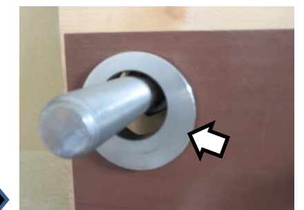
●09 「親フィラー」の取付け ※サイズの適合をチェック
