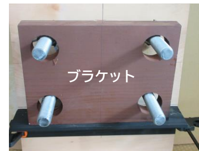
●07 「ブラケット」の取付け ※注入枠(底板)に乗っている状態(鉛直方向位置は固定)
