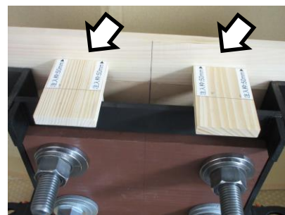
●17 「注入枠(上部補助板)」設置 ※注入枠設置ガイド-50を使用
