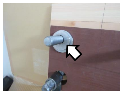
●12 「子フィラー」の取付け ※入らない場合は親フィラーを左右に回転させる
