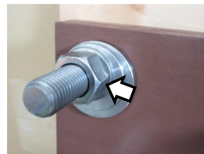
●12 「ナット」の取付け ※最終的にはダブルナット締
