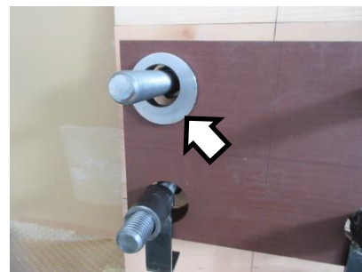
●11 「親フィラー」の取付け ※サイズの適合をチェック
