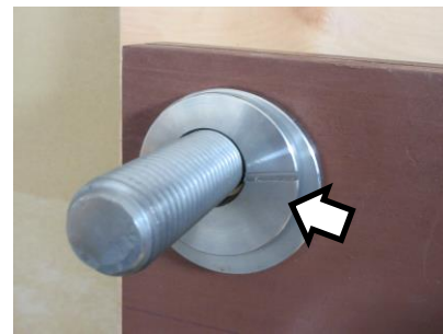
●10 「子フィラー」の取付け ※入らない場合は親フィラーを左右に回転させる
